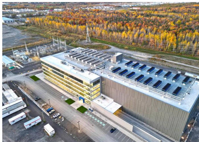
Crédit: MENKES SHOONER DAGENAS LETOURNEUX Architectes
