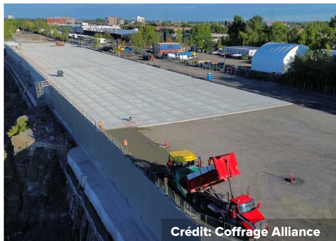
Crédit: Coffrage Alliance
